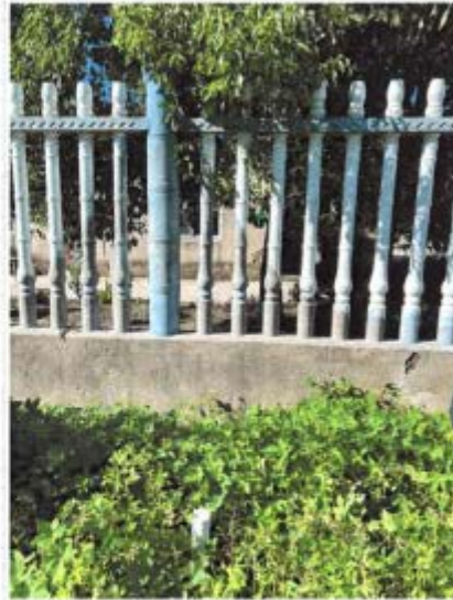
厂区南侧 D4
