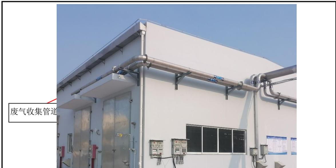
图 3-3 危废仓库贮存废气收集管道照片
