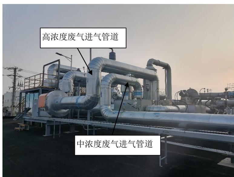
图 6-1 高浓度废气和中浓度废气进气管道照片
