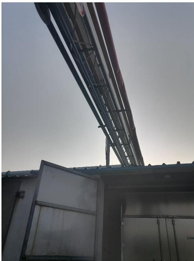
**图 3-2 干燥废气收集管道照片**
