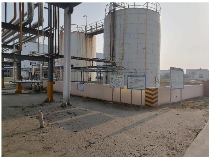
图 3-5 原料罐区围堰照片
