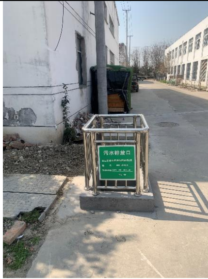
图 3-5 污水排口规范化照片
