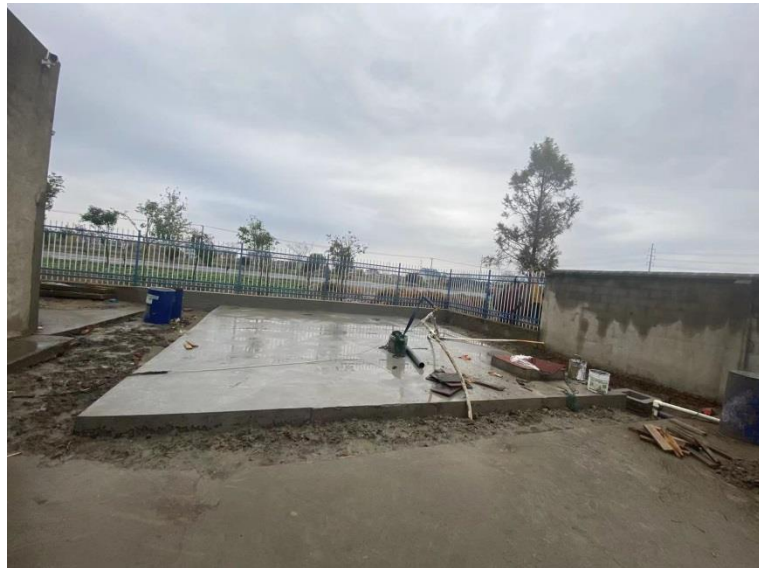
图 3-7 事故应急池照片
