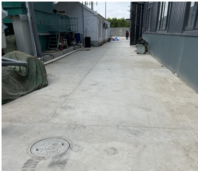
图 3-3 事故应急池照片
