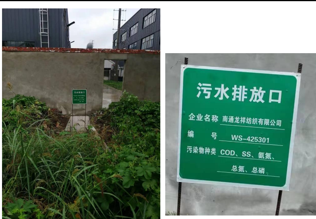
图 3-5 污水排口及污水排口标志牌照片
