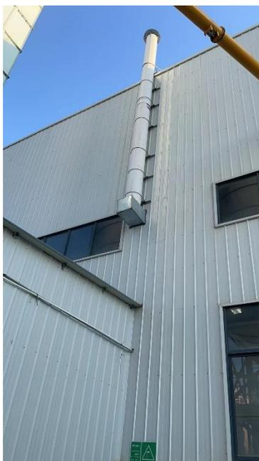
图 3-4 粉磨废气、搅拌、打包废气排气筒照片
