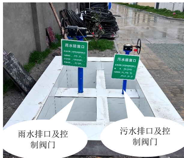
图 3-12 污水排口、雨水排口规范化照片
