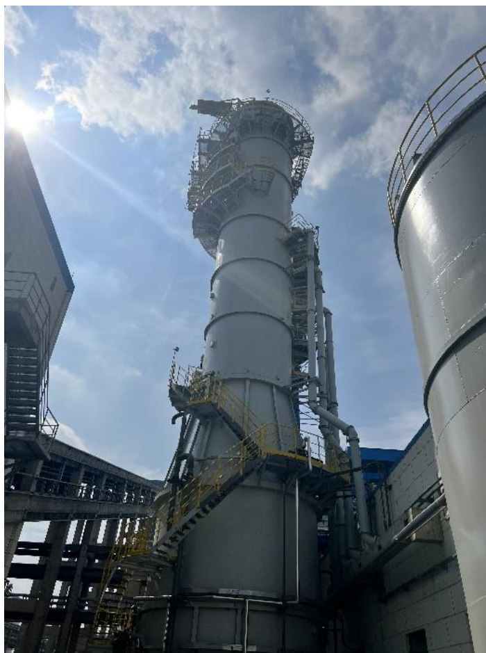
图4.1-7 燃煤锅炉燃烧废气处理装置
