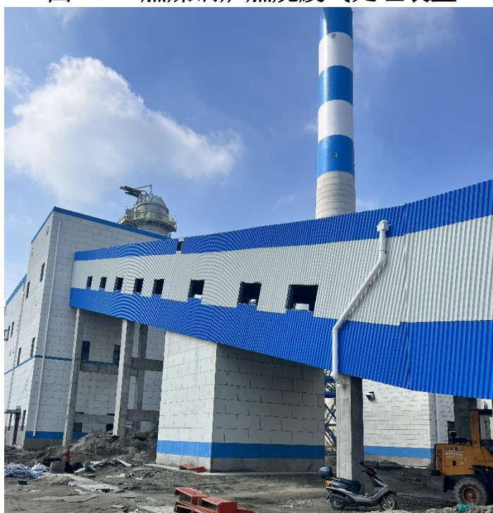
图4.1-8 燃煤锅炉燃烧废气P1排气筒
