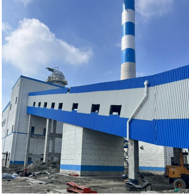
燃煤锅炉废气排气筒P1照片
