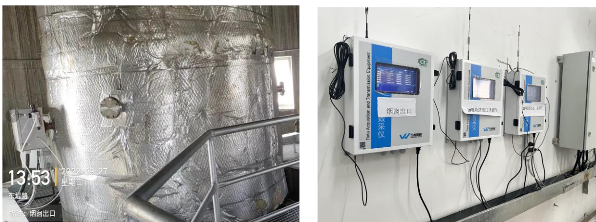
图4.2-3 废气排口自动监控系统照片
