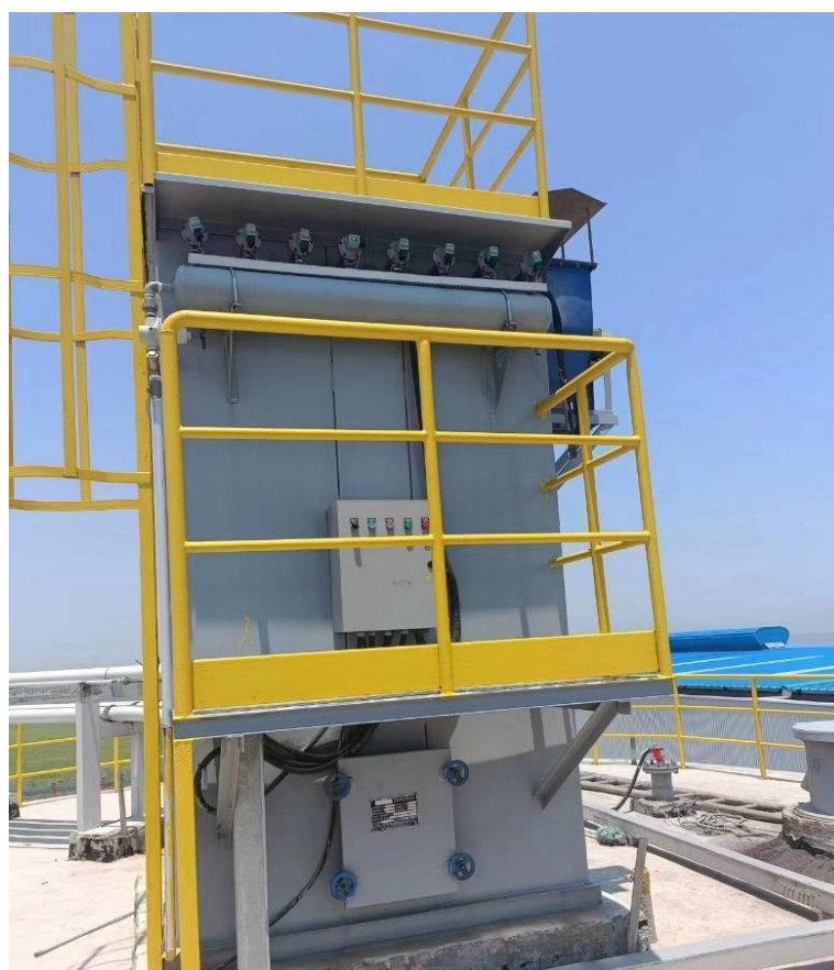
图4.1-12 干灰库粉尘布袋除尘装置
