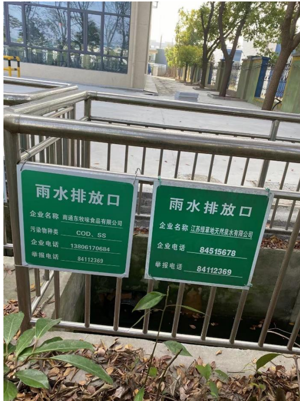
图 3-3 雨水排口规范化照片
