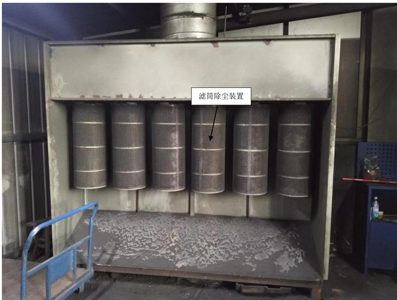
图4.1-6 浇注废气滤筒除尘装置照片
