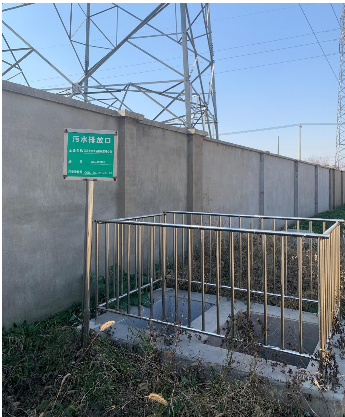
污水排口及标志牌照片
