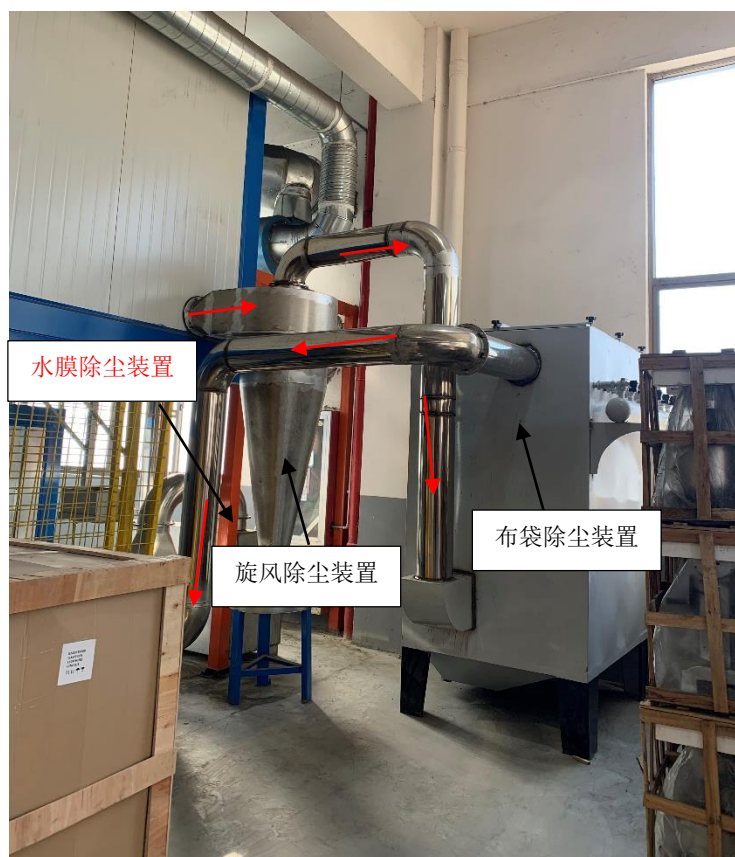
图4.1-11 喷塑线热风炉废气旋风除尘+布袋除尘+水膜除尘装置照片
