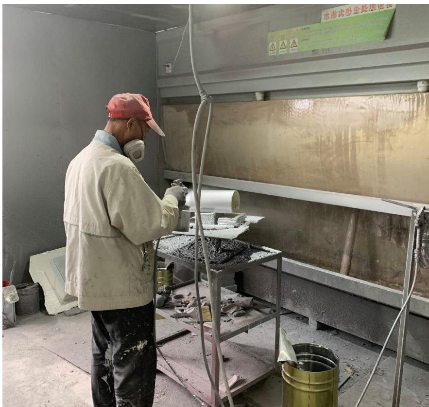
图4.1-13 喷漆废气水帘装置照片
