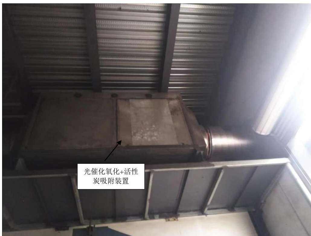
图4.1-5 射芯、浇注废气光催化氧化+活性炭吸附装置照片
