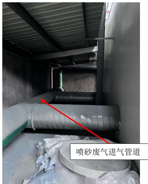
图 7-2 喷砂废气进气管道照片
