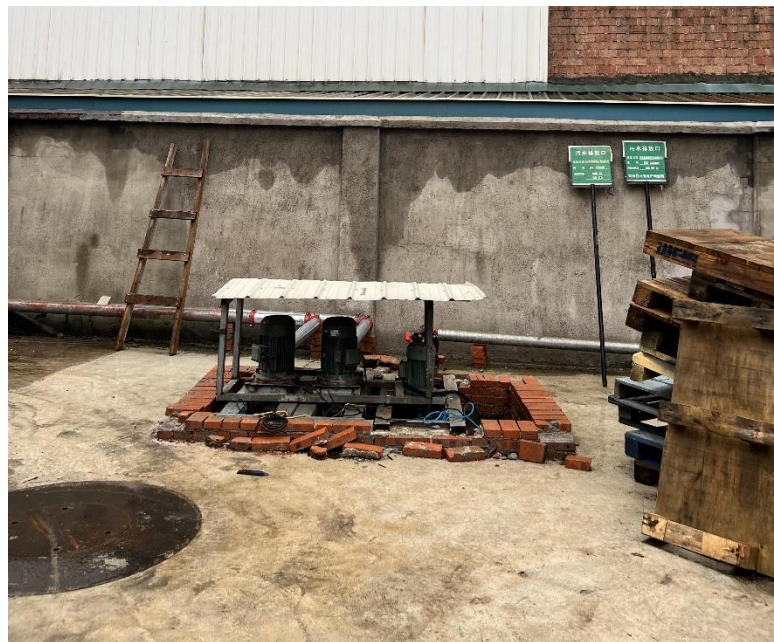
图 3-9 污水排口及标志牌照片
