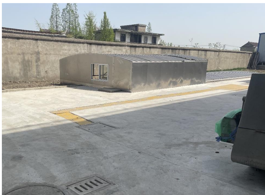
图 3-7 事故应急池照片
