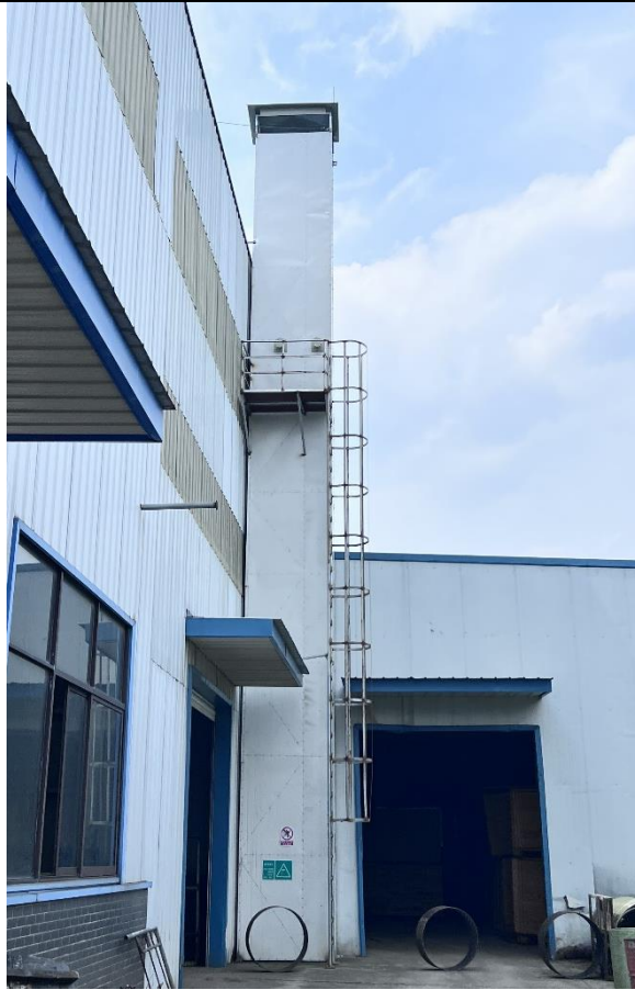
图 3-10 1#排气筒和 2#排气筒照片
