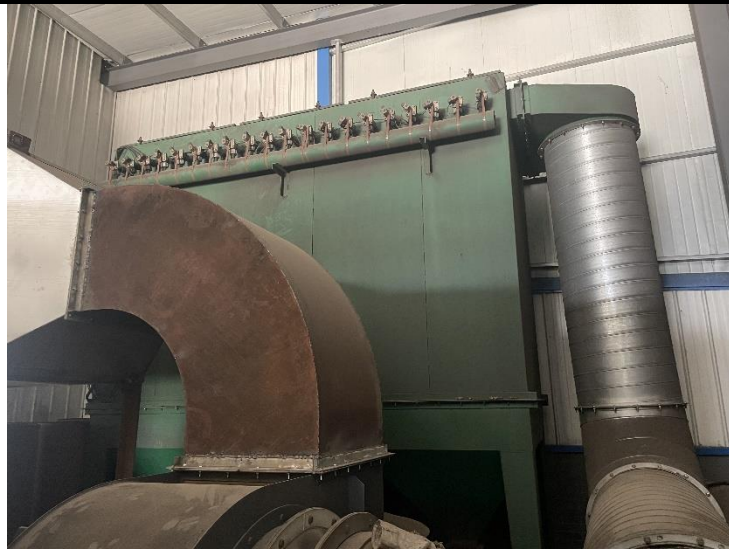
图 3-4 喷砂废气处理设施照片
