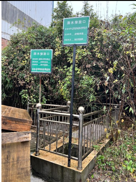
图 3-8 雨水排口及标志牌照片
