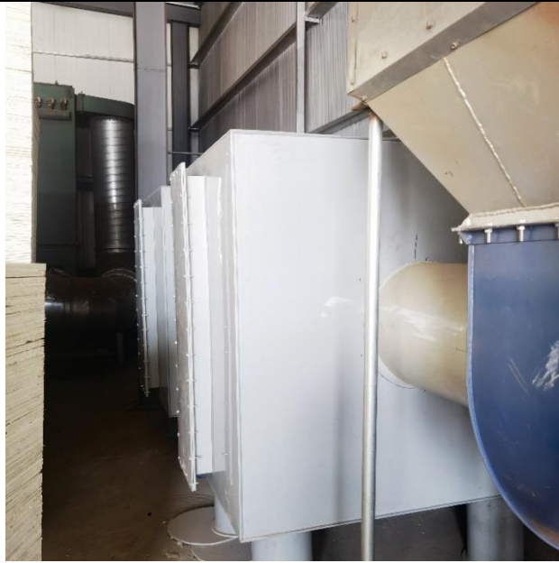
图 3-3 调漆废气、喷漆废气、晾干废气处理设施照片
