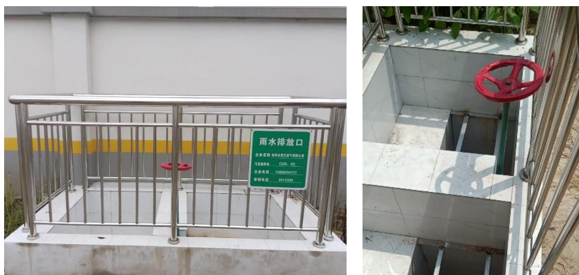
图 3-4 雨水排口及控制阀门
