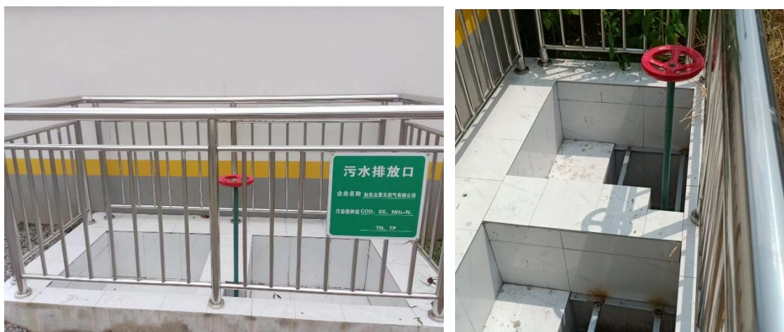
图 3-3 污水排口及控制阀门
