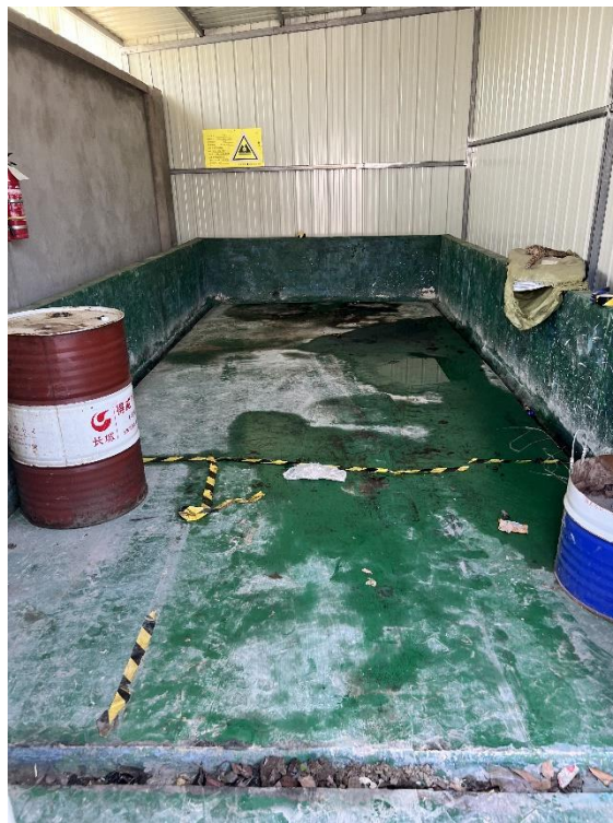
图 3-7 危废仓库内部照片
