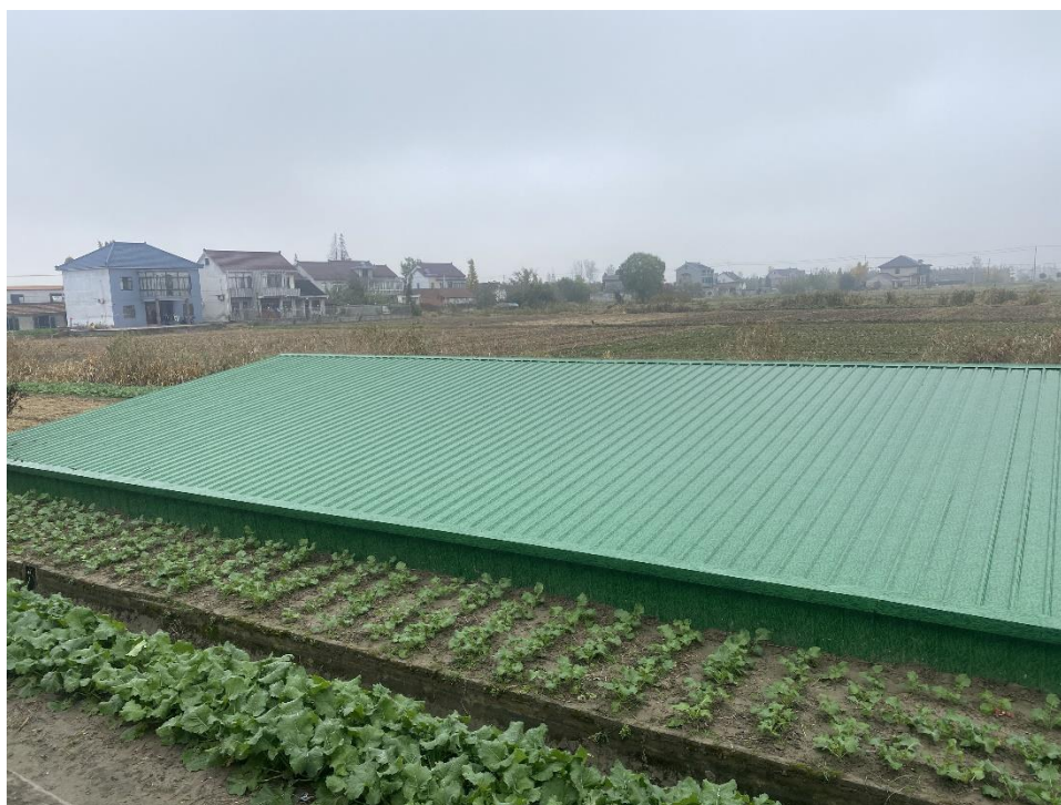
图 3-3 事故应急池照片
