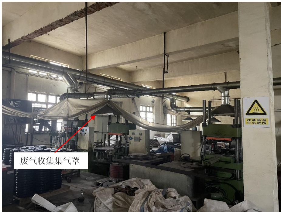
图 3-4 硫化废气收集管道照片
