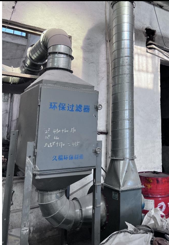
图 3-3 密炼、开炼废气处理设施照片
