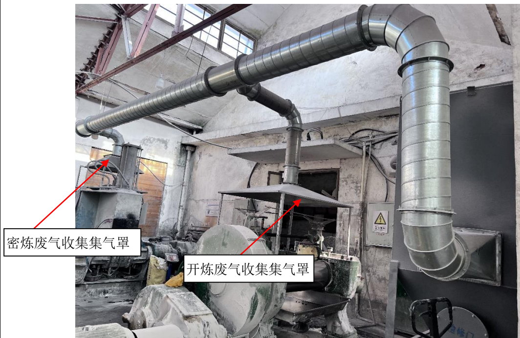
图 3-2 密炼、开炼废气收集管道照片
