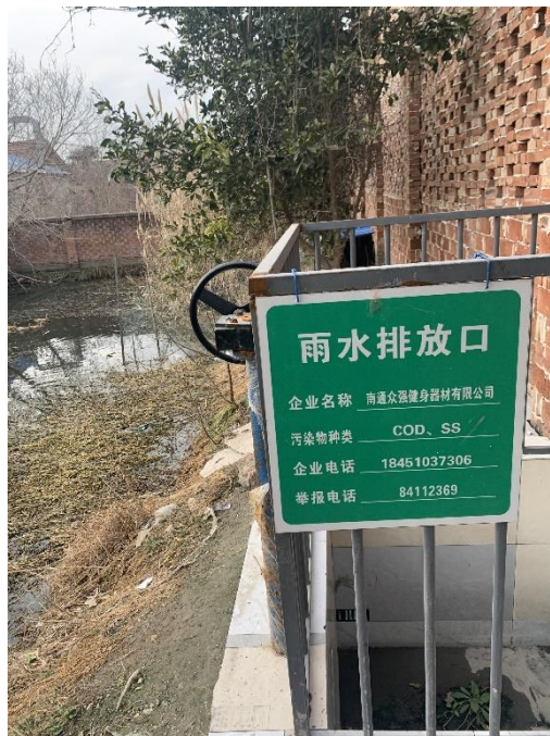
图 3-8 雨水排口及标志牌照片
