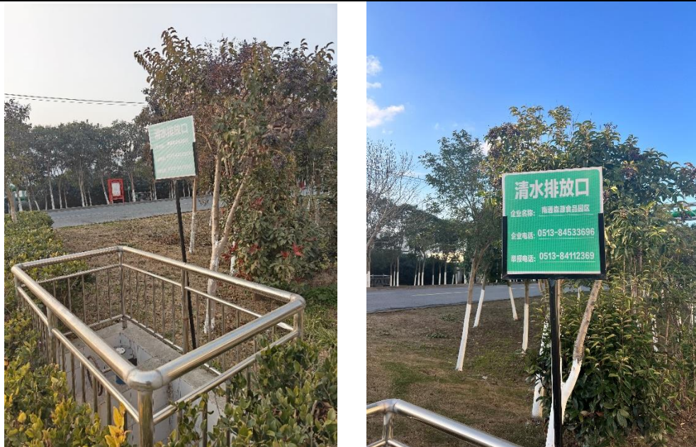
图 3-11 雨水排放口及标志牌照片
