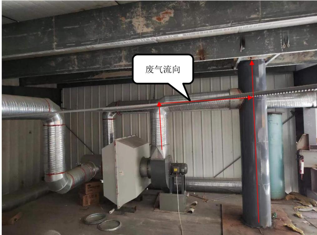
图 3-4 天然气燃烧废气收集管道照片
