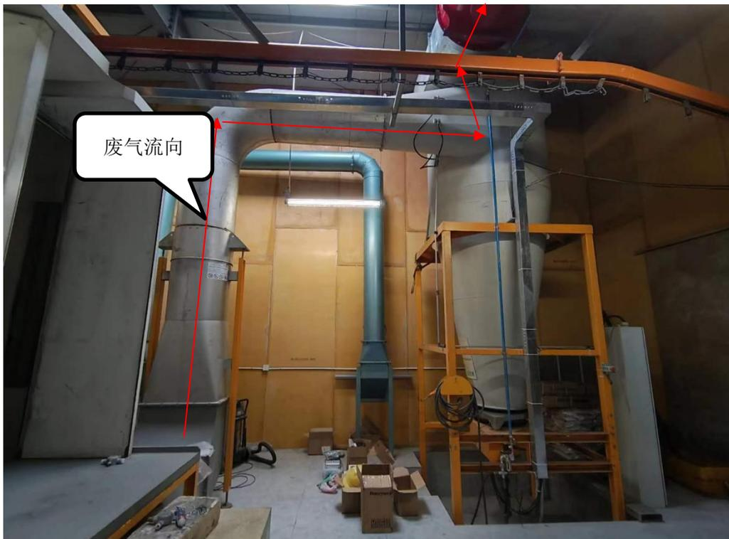
图 3-3 喷塑废气收集管道照片
