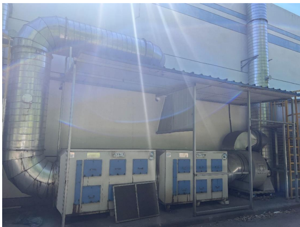
图 3-3 本项目有机废气处理设施照片
