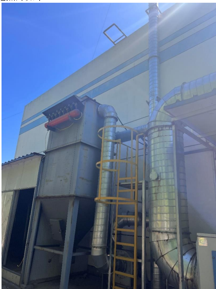
图 3-2 本项目混料及粉碎废气处理设施照片
