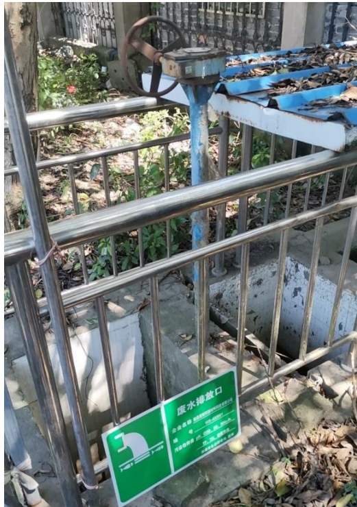
图 3-5 雨水排口及控制闸阀照片
