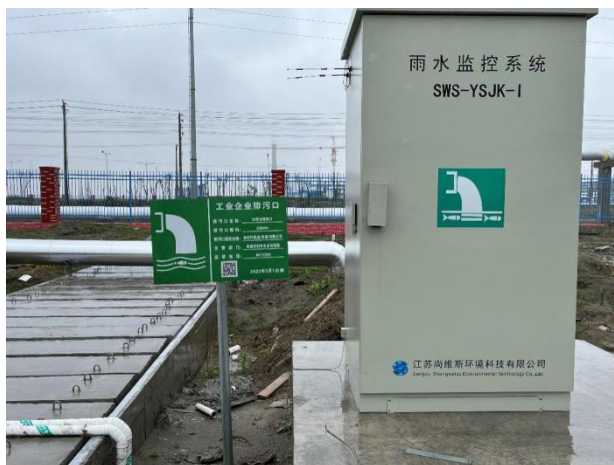
3#雨水排口照片
