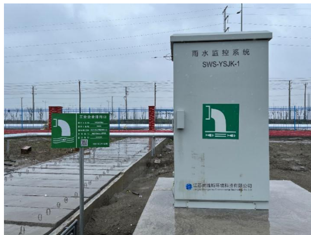
1#雨水排口照片
