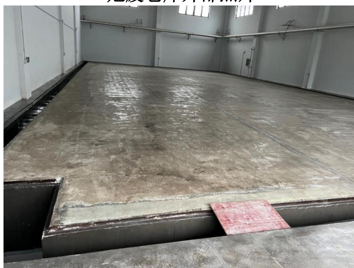
危废仓库内部照片
