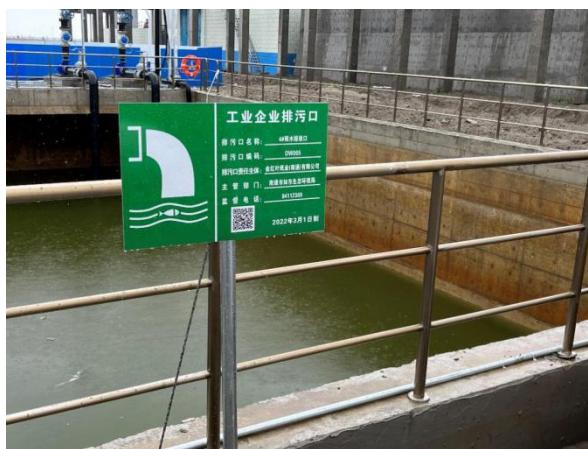
4#雨水排口照片
