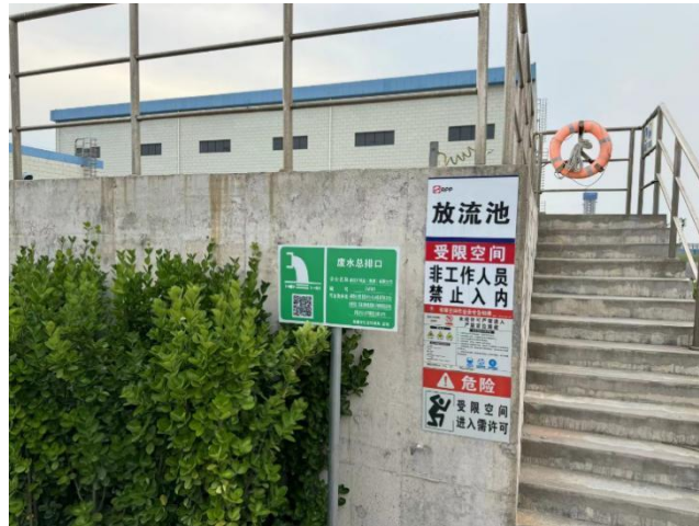
污水排口标志牌
