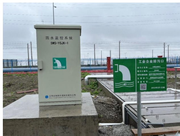
2#雨水排口照片
