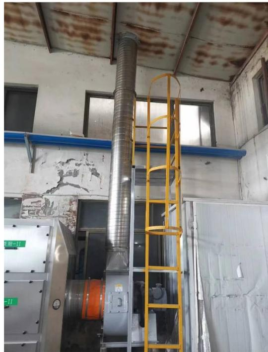
图 3-3 造粒、粘合废气处理设施照片
