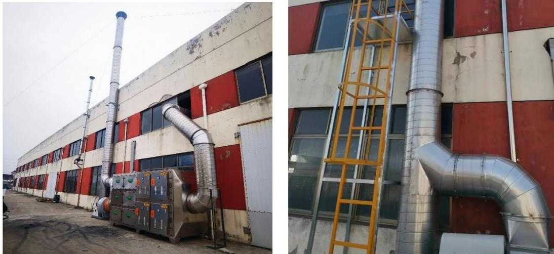
图 3-4 挤管、粘合废气处理设施照片
