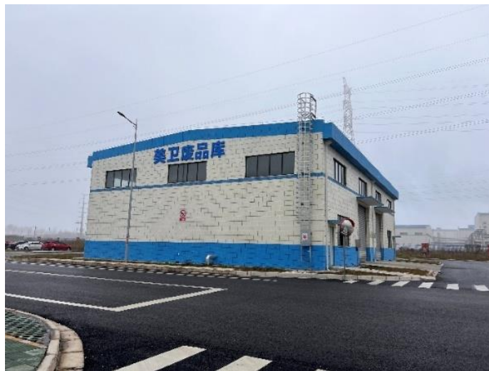
图 3-5 卫品厂区一般固废暂存场以及危废暂存点照片
