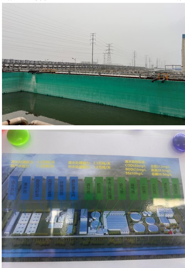
图 3-4 污水处理站级处理设施照片
