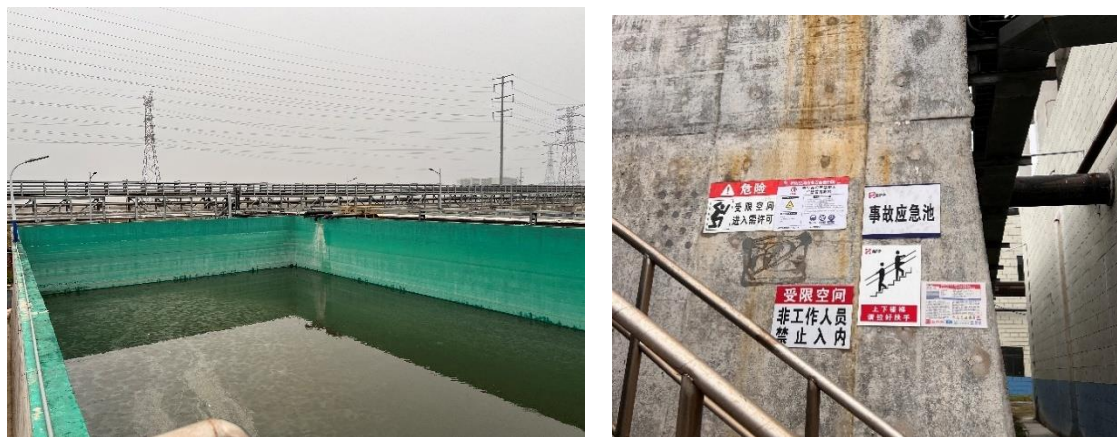
图 3-6 事故应急池照片
