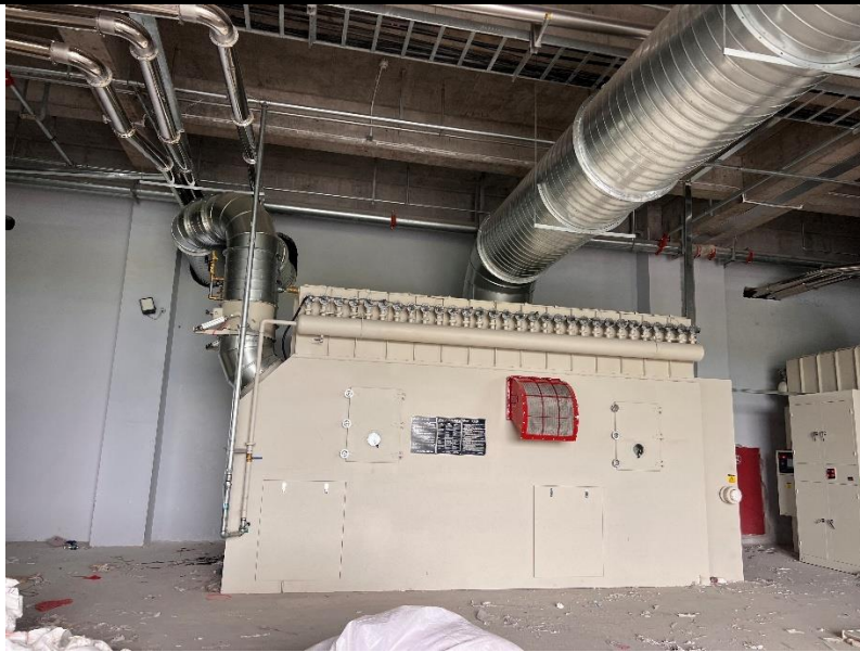
图 3-2 粉碎、成型废气布袋除尘装置照片
