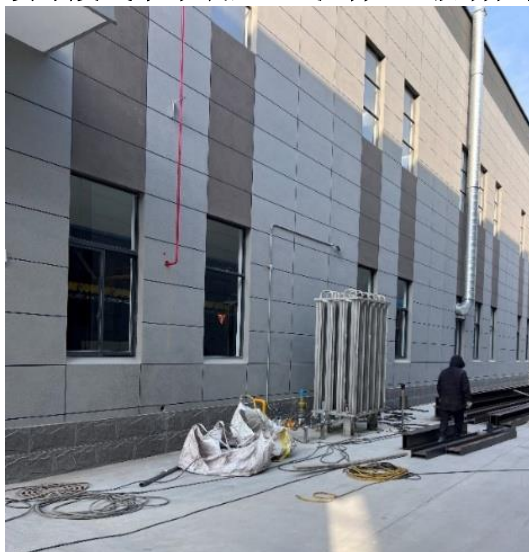
图 3-10 烘干固化、调漆、喷漆、烘干燃烧废气 DA003 排气筒照片
