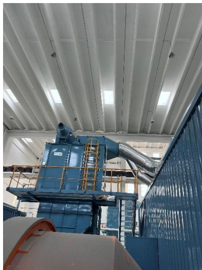
图 3-3 粘土砂落砂废气布袋除尘装置及 DA007 排气筒照片
