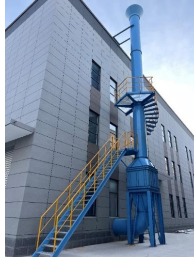
图 3-3 粘土砂落砂废气布袋除尘装置及 DA007 排气筒照片
