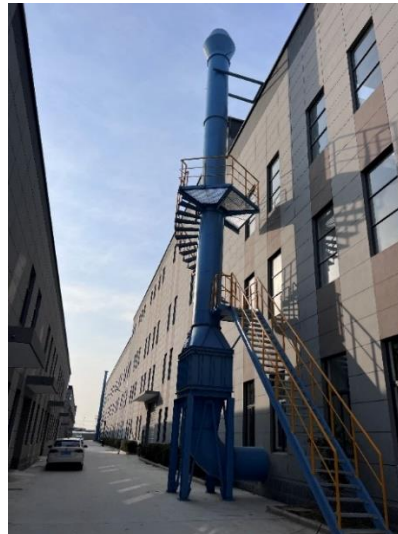
图 3-4 粘土砂混砂、型砂回收废气布袋除尘装置及 DA008 排气筒照片
