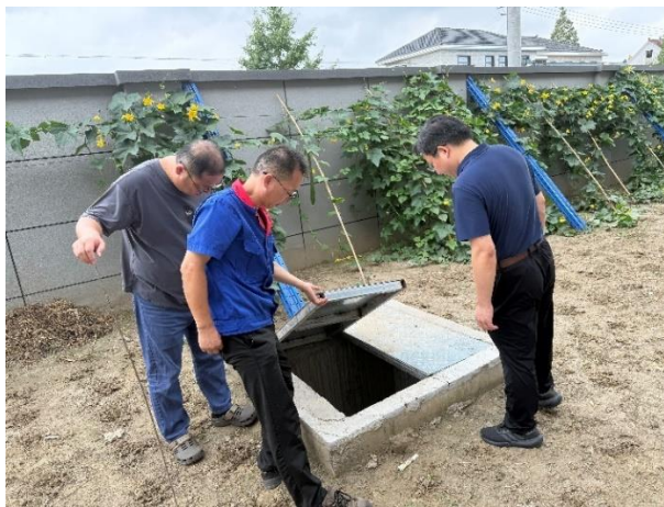
图 3-18 初期雨水池照片
