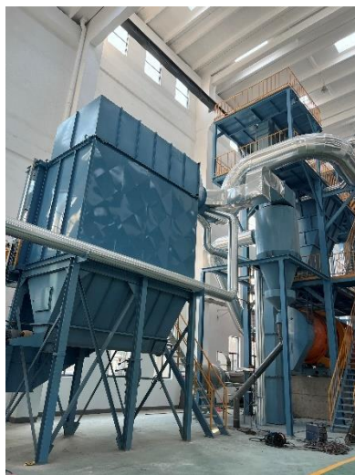
图 3-4 粘土砂混砂、型砂回收废气布袋除尘装置及 DA008 排气筒照片
