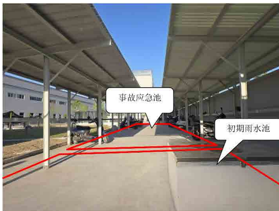
图 3-7 事故应急池、初期雨水池照片
