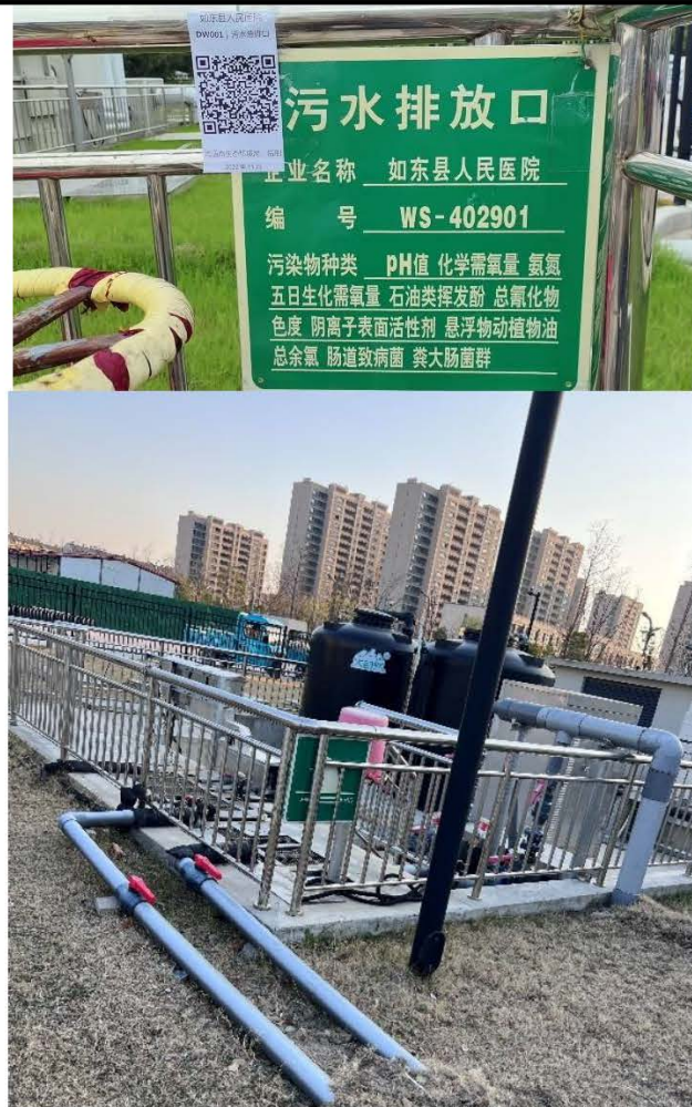
图 3-8 废水排放口及标志牌照片
