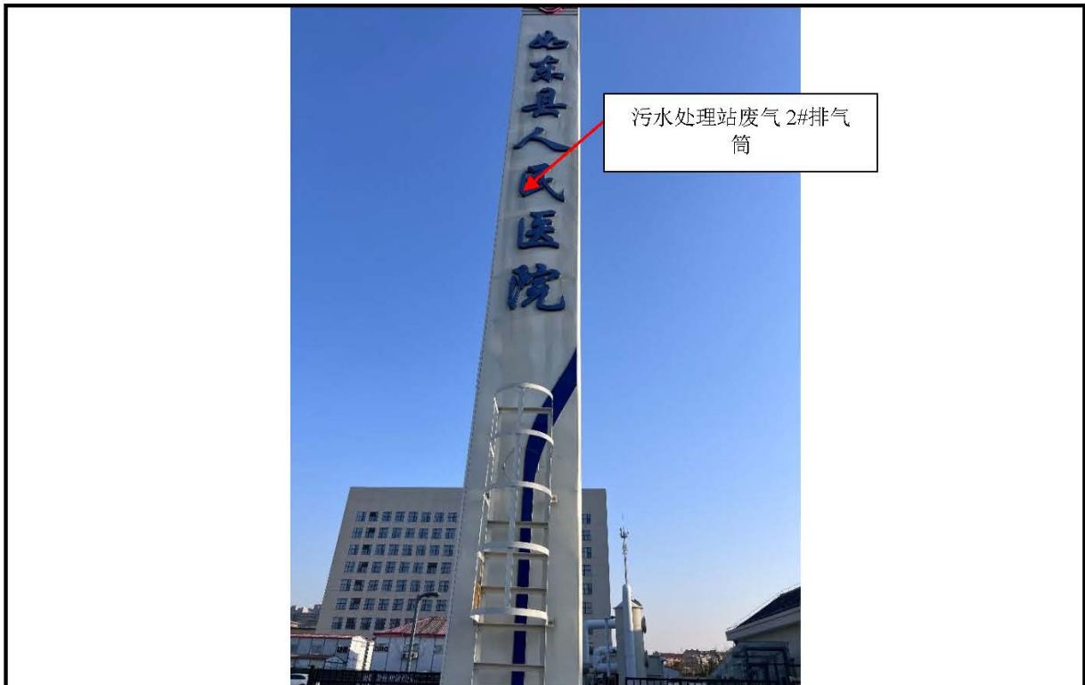
图 3-4 污水处理站废气 2#排气筒照片
