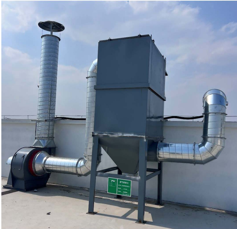
图 3-5 布袋除尘装置废气处理设施照片
