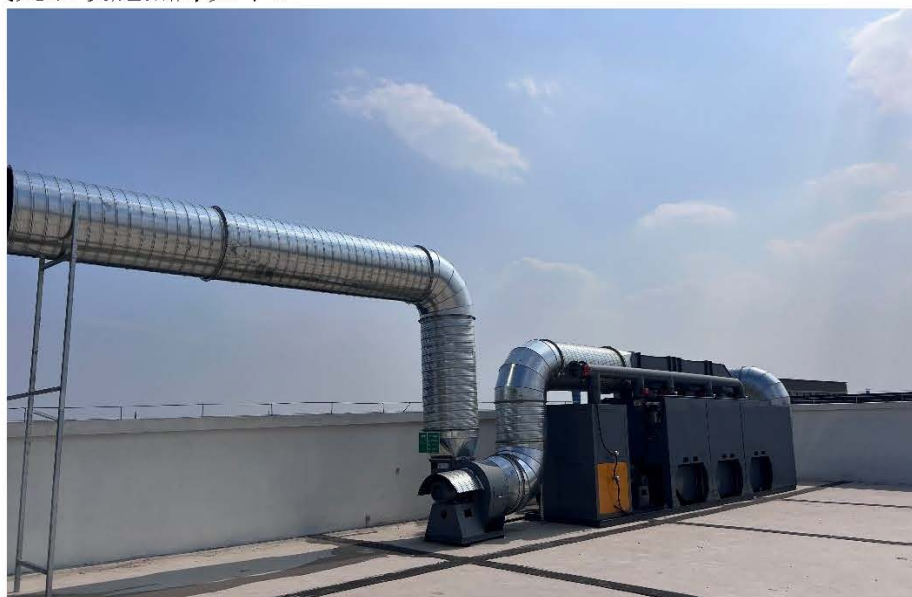
图 3-2 干式过滤+活性炭吸脱附+CO 催化燃烧装置废气处理设施照片
