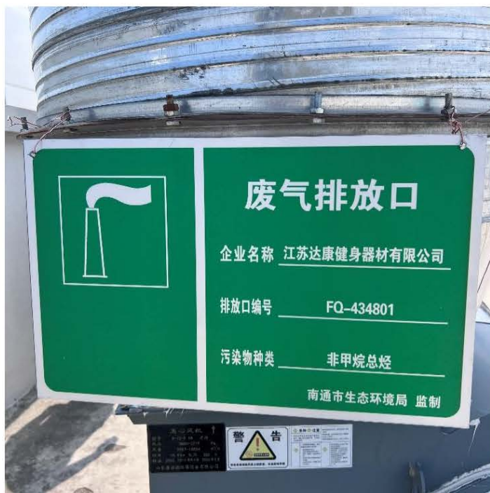
图 3-9 FQ-434801 排气筒照片
