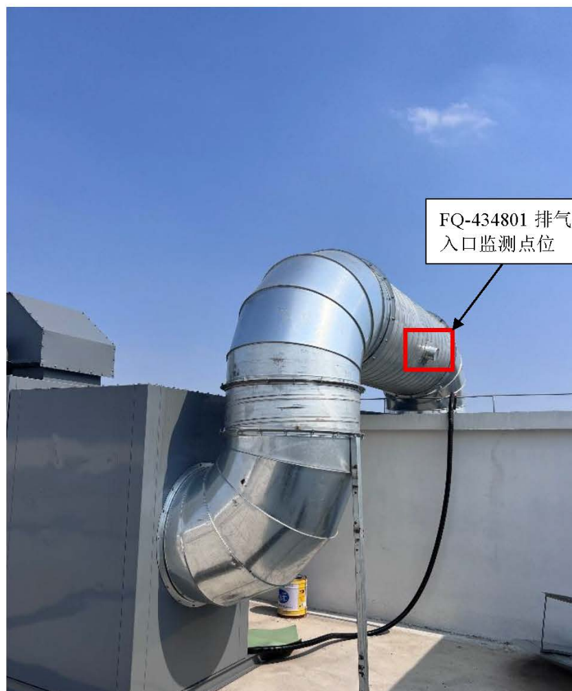
图 3-3 FQ-434801 排气筒进口监测点位
