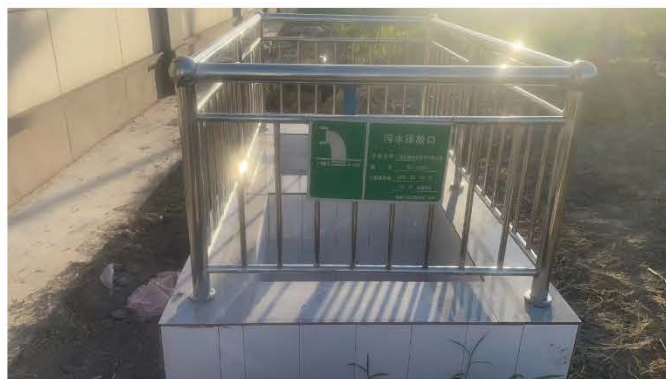
图 3-11 污水排口及标牌照片
