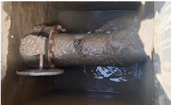
事故应急池控制阀门照片
