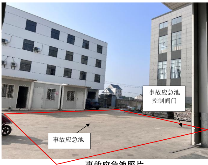
事故应急池照片
