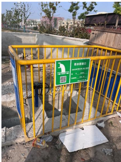
雨水排口及标志牌照片
