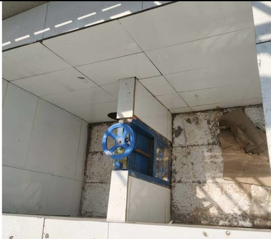
图 3-6 污水排口及标牌照片
