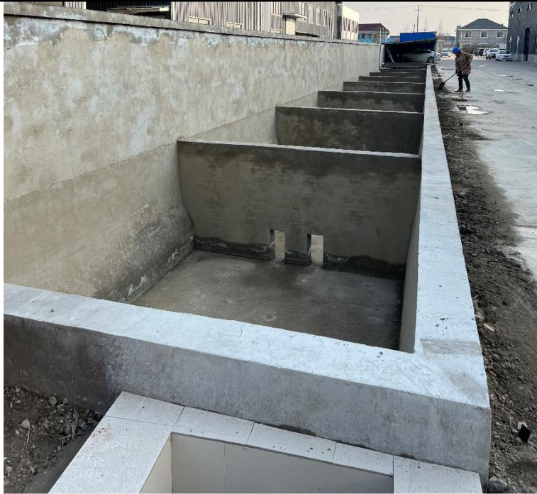
图 3-5 事故应急池照片
