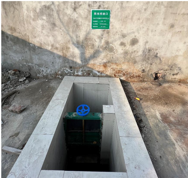
图 3-6 雨水排口及标志牌照片
