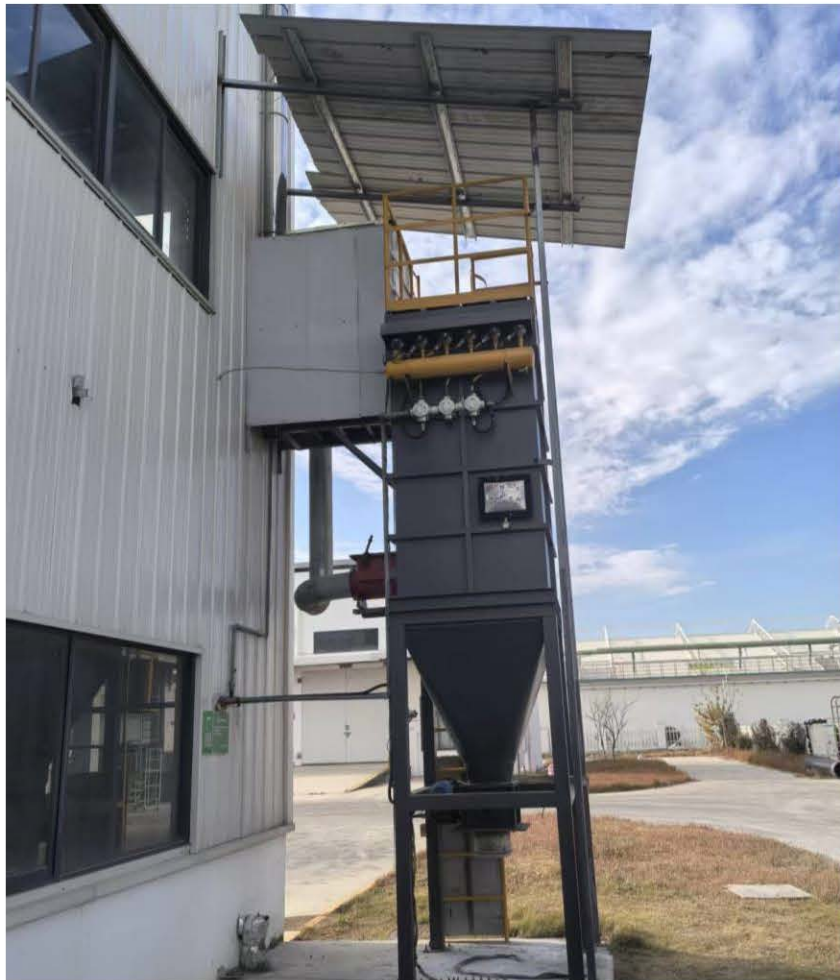
图4.1-3 电石粉尘布袋除尘器
