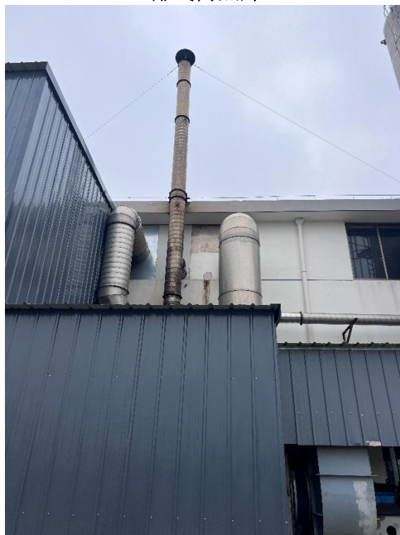
图 3-2 车间一 3 条 PU 浸胶线工艺废气、调胶废气三级水喷淋装置及 FQ328401 排气筒照片
