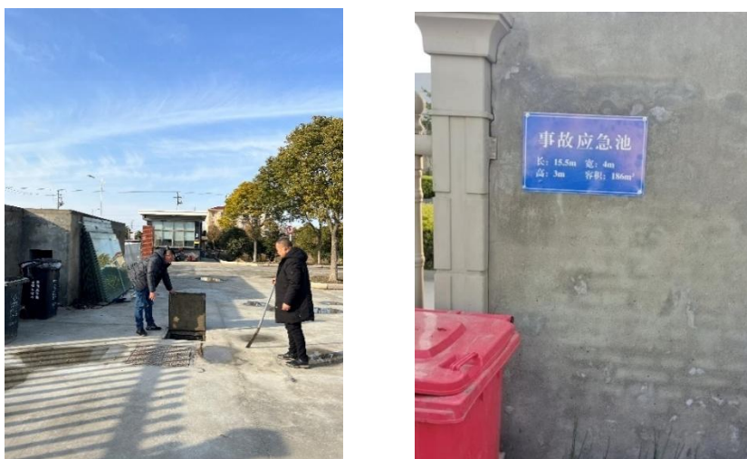
图 3-8 事故应急池照片
