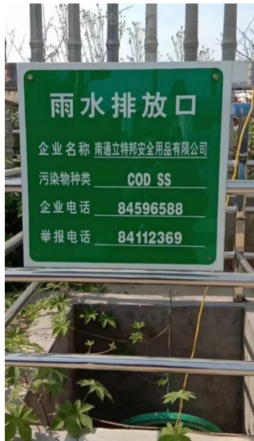
图 3-11 雨水排放口及标志牌照片
