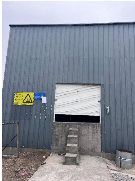
图 3-7 DMF 废水储罐照片
