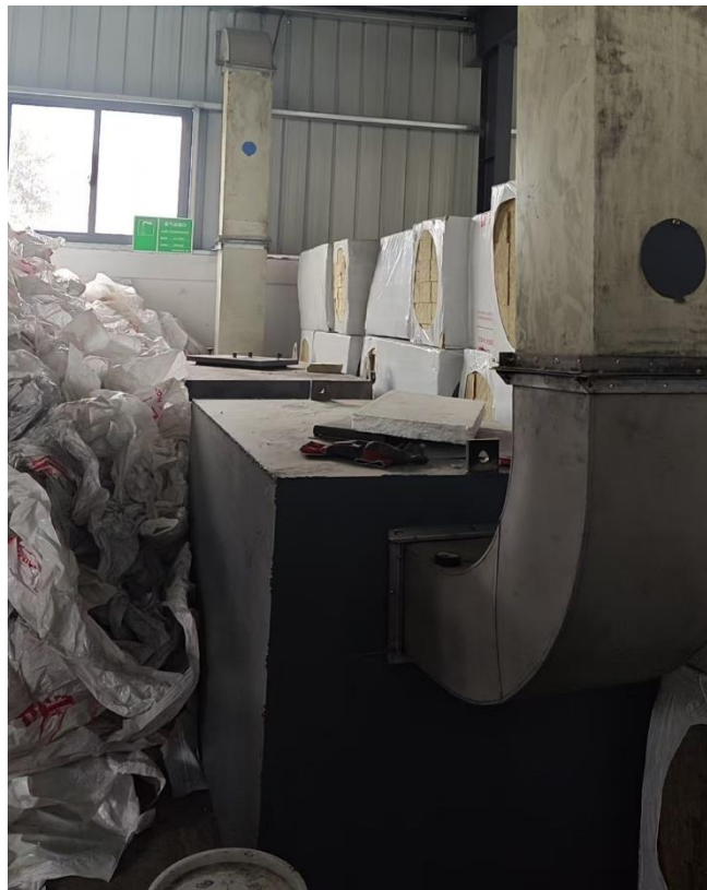
图 3-3 发泡、上胶、复合废气处理设施照片
