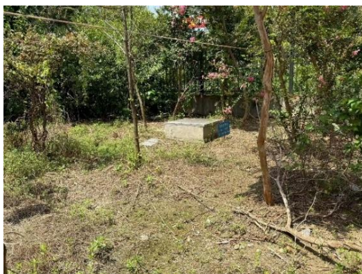
图 3-11 事故应急池照片
